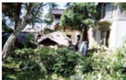
震災で倒壊した家
